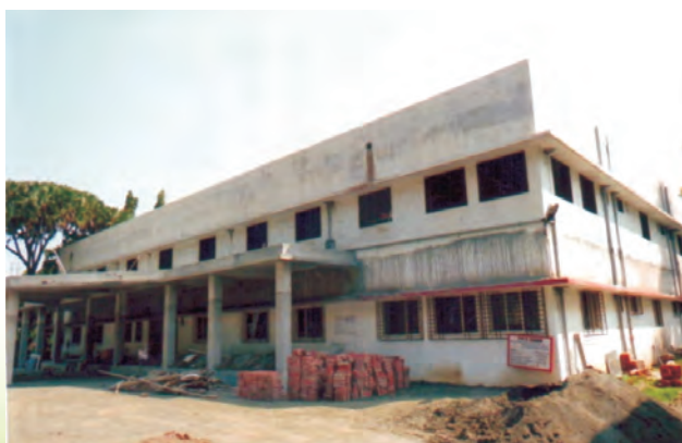
राजकीय चिकित्सालय मारवाड़, नानी दमन में ओ पी डी ब्लॉक का निर्माण
