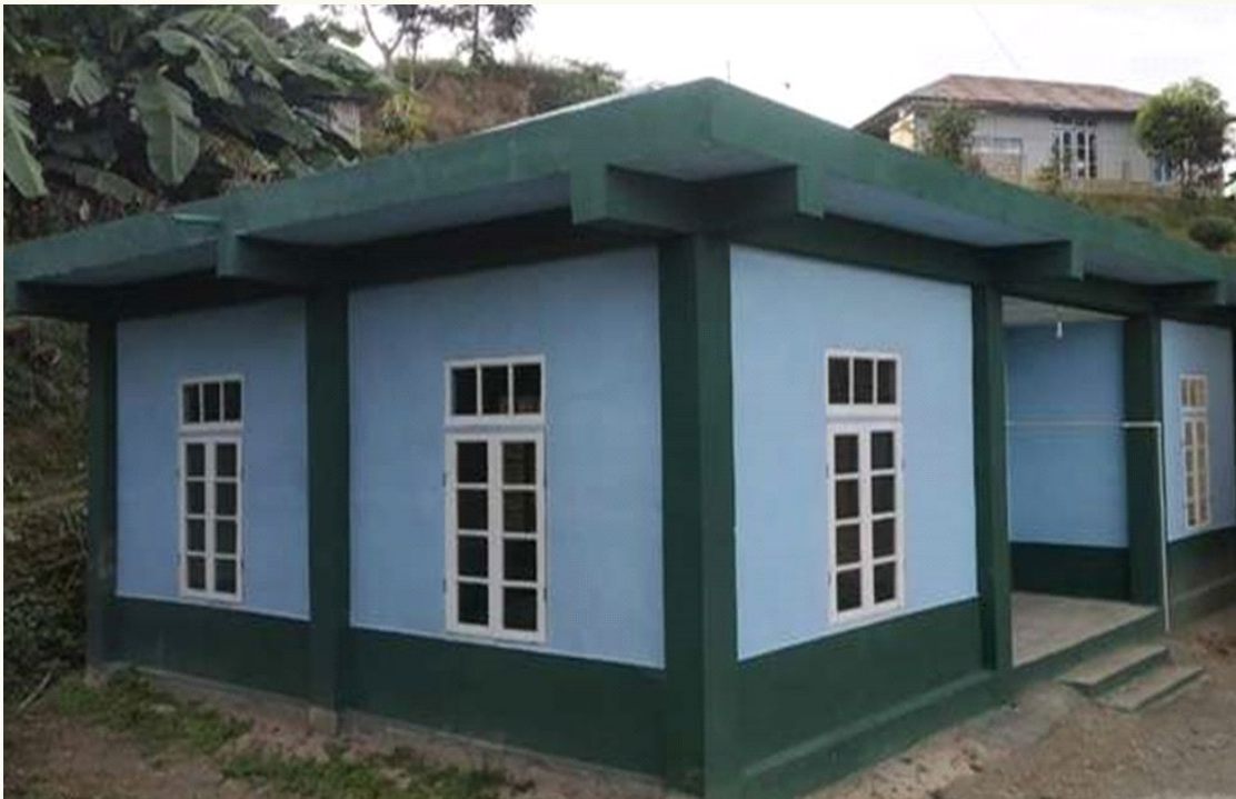
गांव-दक्षिण वनलाईफाई, ब्लॉक-हनहथियाल, जिला-हनहथियाल, मिजोरम में स्वास्थ्य उप-केन्द्र भवन का निर्माण, कार्य पूरा होने की तारीख - 22.03.2021
