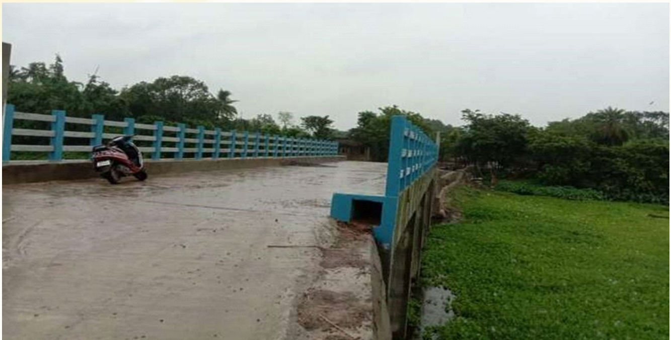
गांव - हबसपुर मोती महल, ब्लॉक - भगवानगोला -I, जिला मुर्शिदाबाद, पश्चिम बंगाल में संपर्क सड़क के साथ भैरब नदी पर बड़ी पुलिया का निर्माण, कार्य पूरा होने की तारीख - 15.06.2021
