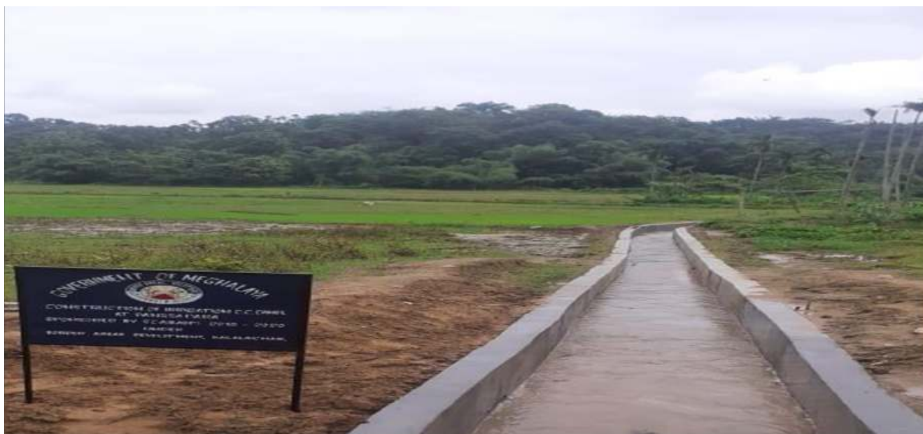
गाँव: दांगसापारा, ब्लॉक: कलईचर जिला: साउथ-वेस्ट गारो हिल्स (मेघालय) में सिंचाई नहर का निर्माण, कार्य पूरा होने का वर्ष: 2020-21
